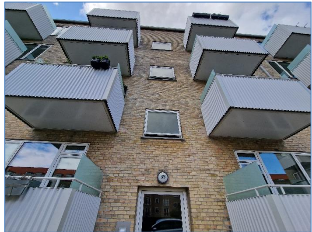
Foto 2: Vindue til opgang
