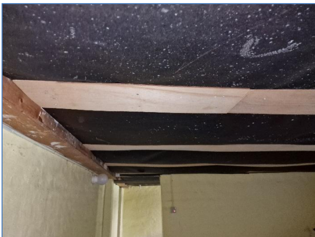
Foto 3: Etageadskillelse efterisoleret
