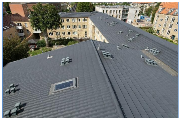
Foto 2: Udluftninger på skråtag
