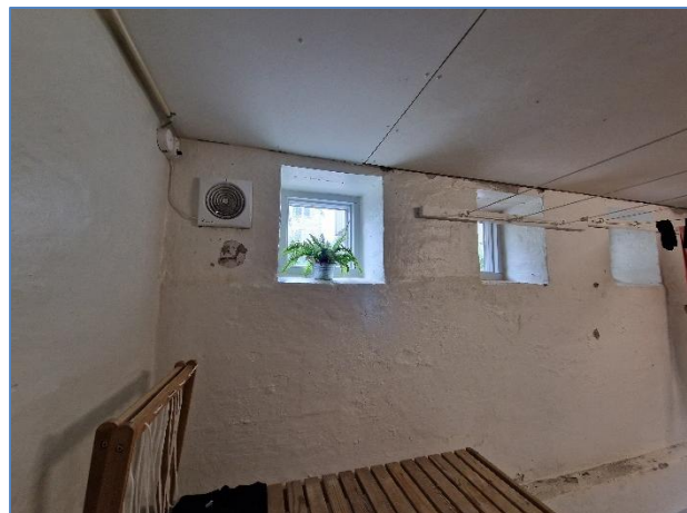
Foto 4: Etageadskillelse, pladebeklædning
