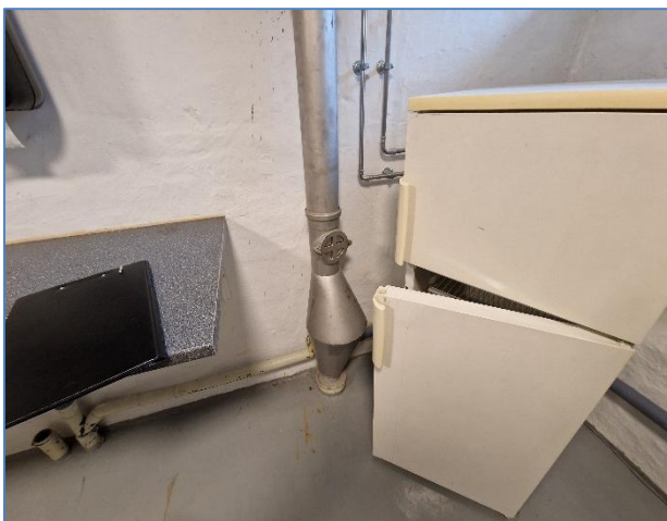
Foto 3: Faldstamme med rottespærre
