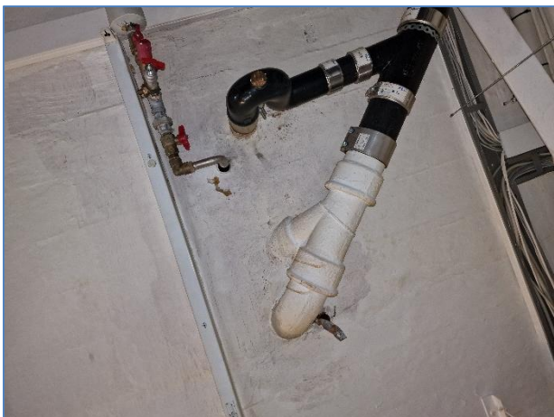
Foto 3: Styringsventiler i kælder
